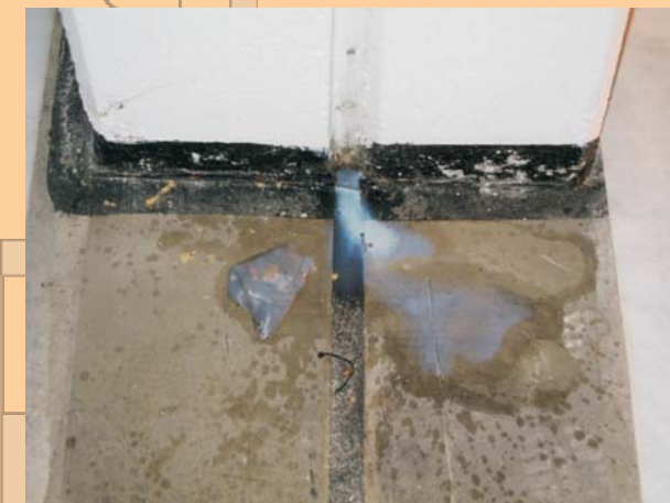
Bild oben: Tiefgaragestütze / Dehnfuge
