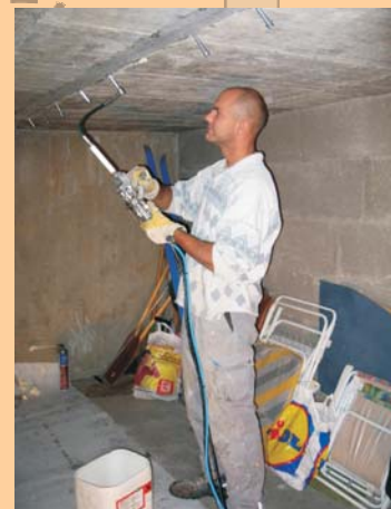
Gel - Techniker bei einer Schleierinjektion einer TG - Dehnfuge!
