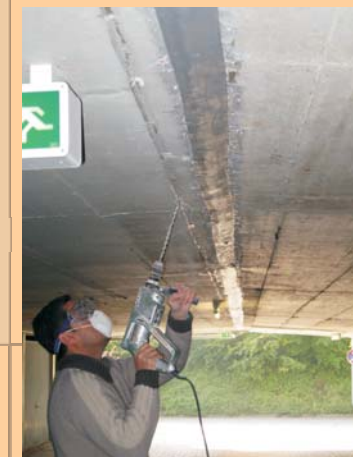
Gel - Techniker bei einer Schleierinjektion einer TG - Dehnfuge!
